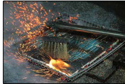
6_ Rimozione dello strato di segatura 6_ The sawdust coat is removed
